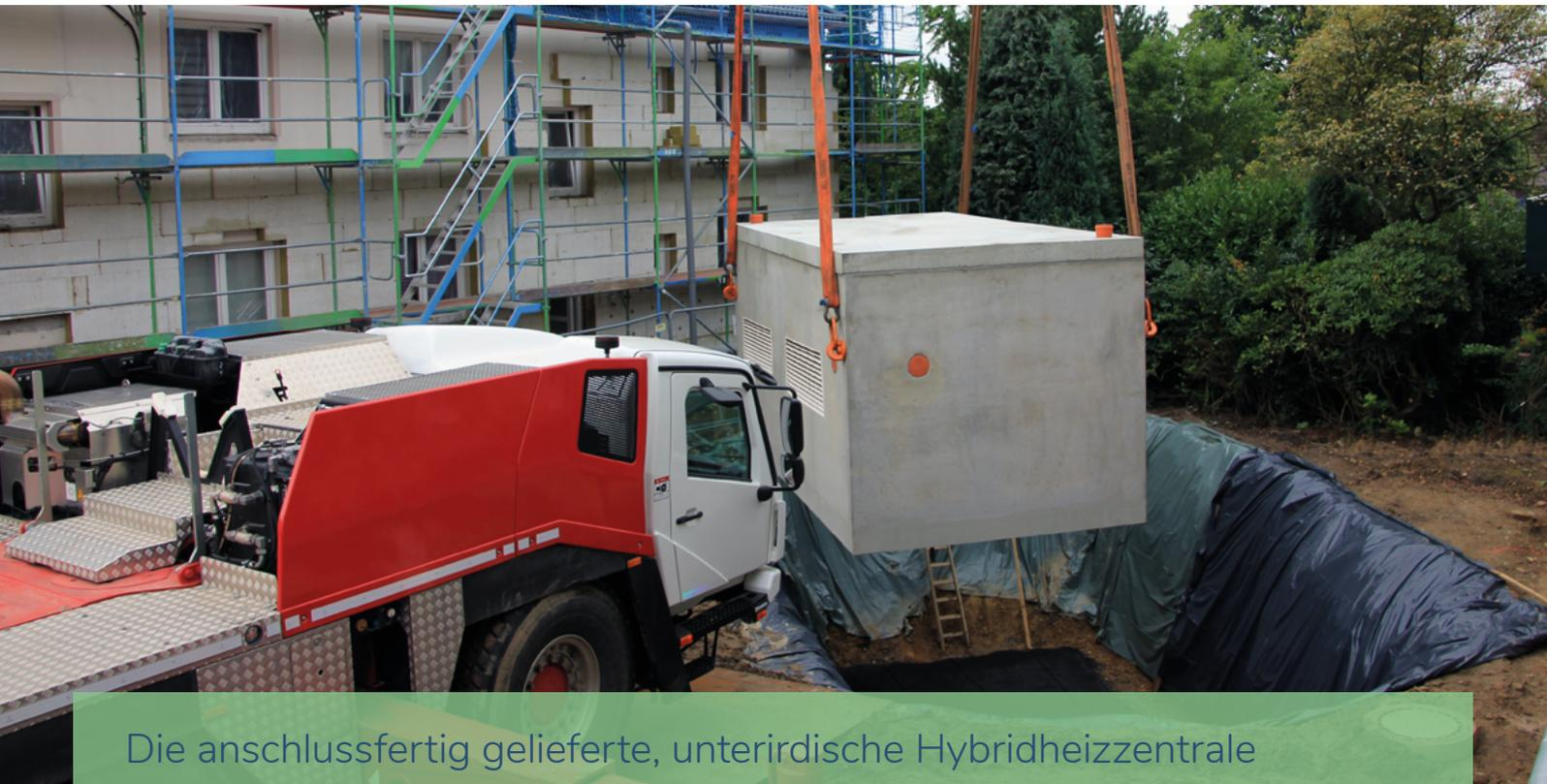
Die anschlussfertig gelieferte, unterirdische Hybridheizzentrale
