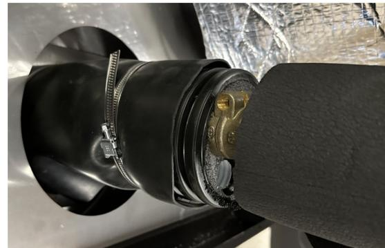
Abbildung: Fernwärmeanschluss von unten in den HOME CUBE Tower eingeführt
