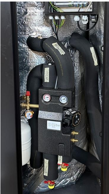
12. Schwarzen Würfelstecker an der schwarzen Anschlussdose des Schaltschranks des HOME CUBE Towers anstecken und Sicherungsbügel einrasten.
