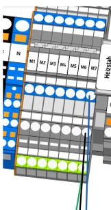
9. Heizstab (wenn vorhanden) auf Klemme X Heizstab - L1, N, PE korrespondierend anschließen.
