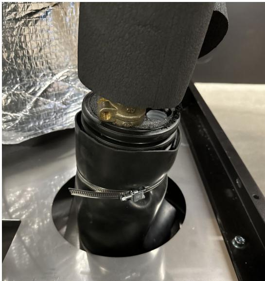
Abbildung: Fernwärmeanschluss von der Rückseite in den HOME CUBE Tower eingeführt
