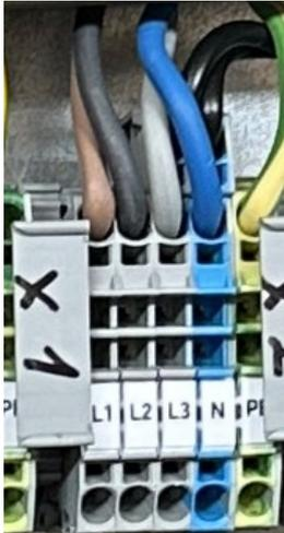
2. PVC-Schlauchleitung H05VV-F 3G x 0,75 (230 V Primärkreispumpe) an Klemmleiste X3 auf L1, N, PE korrespondierend anschließen.
